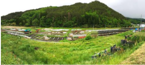
太陽光発電所工事の様子（5月22日現在）
