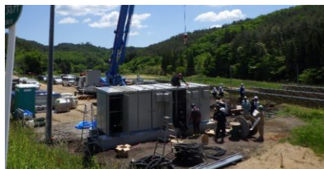
キュービクル設置工事の様子（5月29日）
